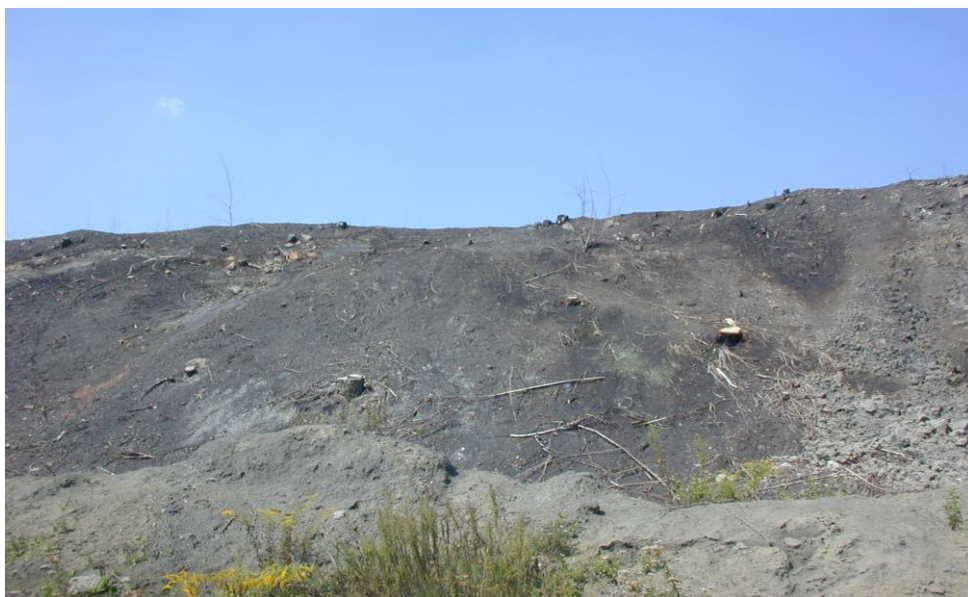
Obr. 4: Intenzivně zasažená část odvalu endogenním a povrchovým požárem – zdroj prašnosti (centrální plošina odvalu Heřmanice)
