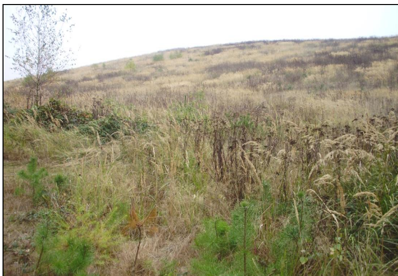
Obr. 7: Sanace termické aktivity aplikací těsnící vrstvy – Krimich
