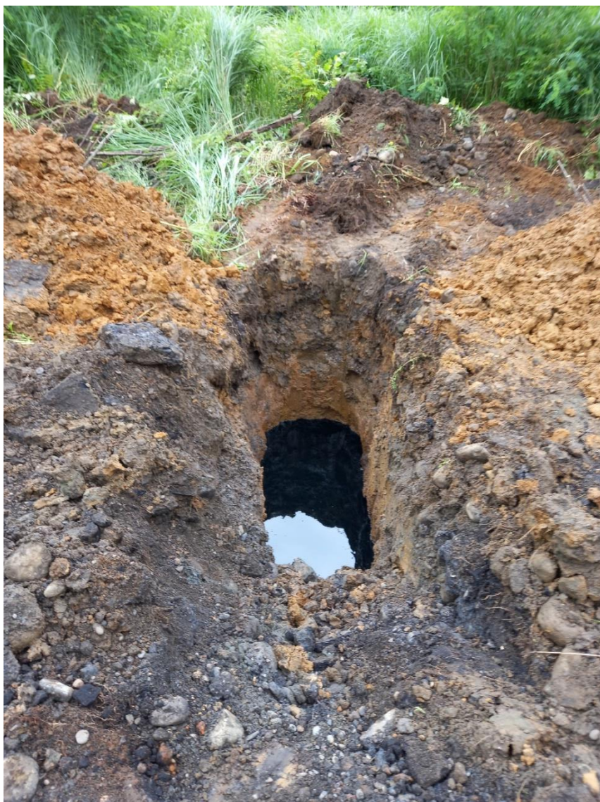
Obr. 2: Zemní sonda pro odběr vzorků zemin a měření mocnosti ropné fáze na hladině podzemní vody
