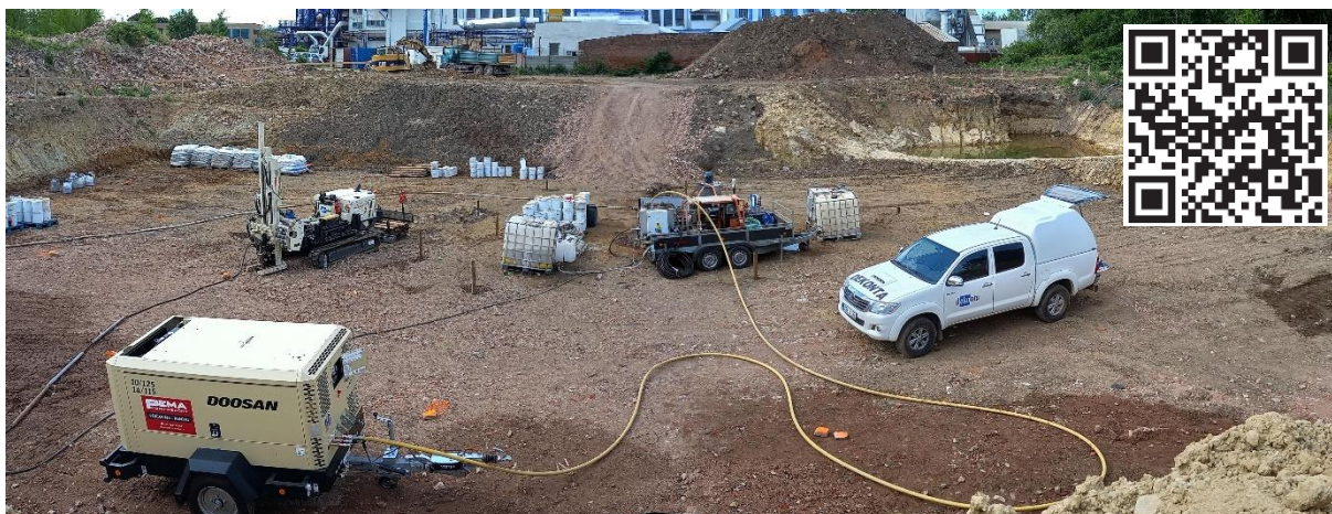
Obr. 3: Sestava vysokotlaké injektáže (Frac-In) v sanačním výkopu pod bývalou odmašťovnou (viz ilustrativní video pod QR kódem).
