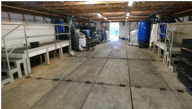
Obr. 1b: Dekontaminační stanice DS1
