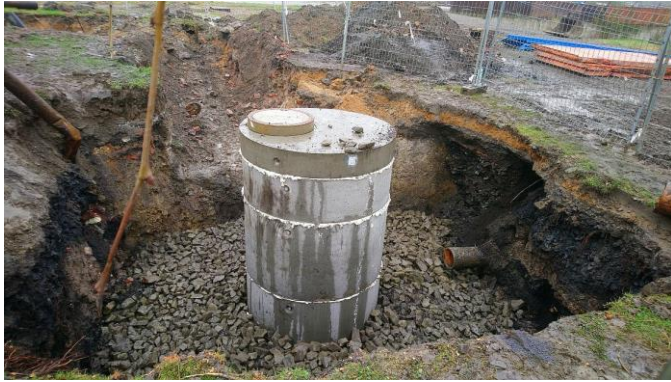
Obr. 2b: Zasakovací šachta a drenáž
