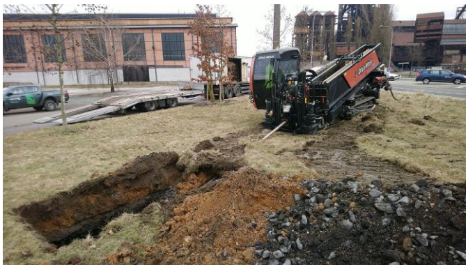
Obr. 2a: Horizontální podvrty
