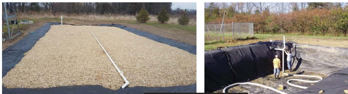
Obr. 1: Pohled na full-scale denitrifikační štěpkový bioreaktor provozovaný na území provincie Ontario v Kanadě [2].
