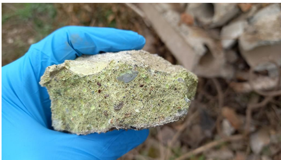
Obr. 1: Kompletně prosycené základové konstrukce chromem.
