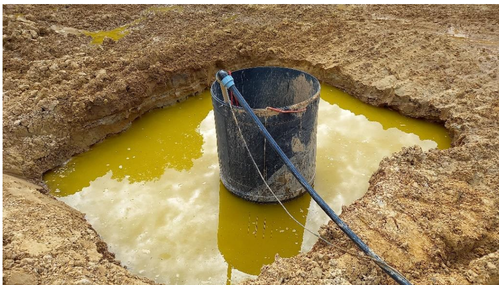
Obr. 2: Stavebně-sanační čerpání vod bohatých chromem
